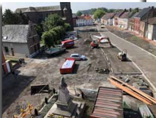
Travaux Place de Bernissart
