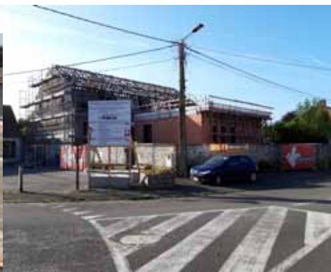
Aménagement de la crèche à Ville-Pommeroeul
