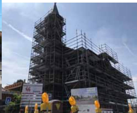
Restauration de la Maison Communale à Bernissart
