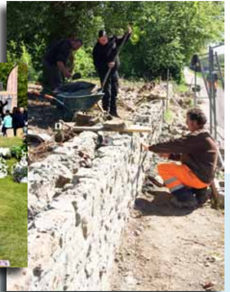
Réfection d'un mur le long du Canal d'Ath
